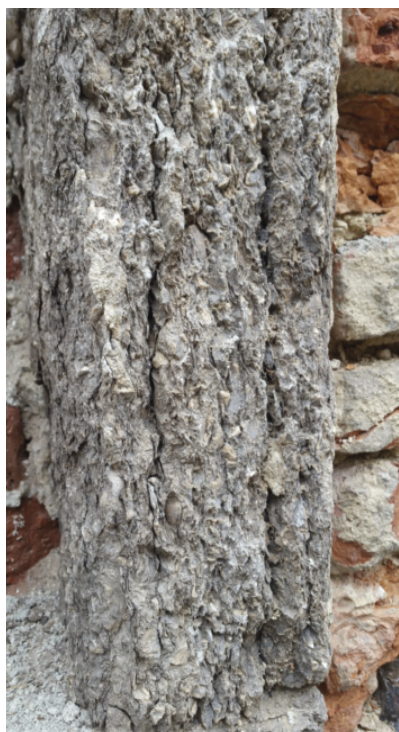
Abspaltender Fohnsdorfer Muschelkalk als Ergebnis der Witterungseinflüsse
