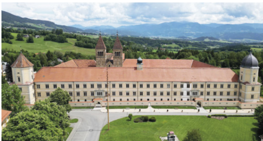
Westfassade der Abtei mit bereits renovierter Musterachse
