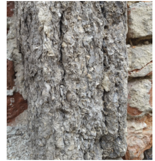
Abspaltender Fohnsdorfer Muschelkalk als Ergebnis der Witterungseinflüsse
